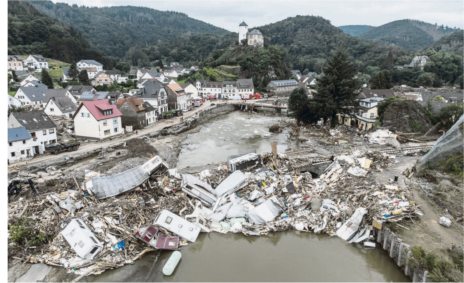
Meterhoch türmen sich Wohnwagen, Gastanks, Bäume und Schrott an einer Brücke über der Ahr bei Altenahr
